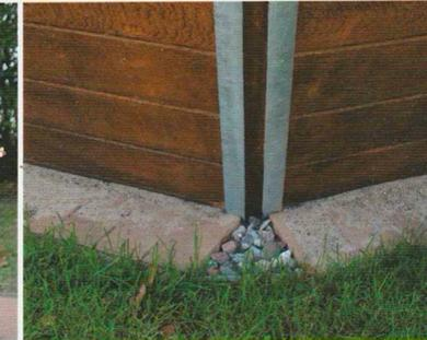
Die tragende Konstruktion besteht aus feuerverzinktem Metall. Wasserabweisendes Hartholz in der Aussenbeplankung und das nichtrostende Innere gewährleisten eine lange Lebensdauer.
